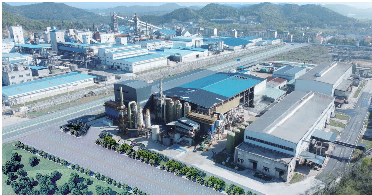
江西泰品新能源有限责任公司年产 6000 吨碳酸锂项目 Jiangxi Taipin New Energy Co., Ltd. 6,000 t/a Lithium Carbonate Project
