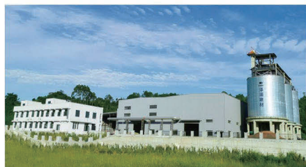
01- 重庆水务集团有限公司 (601158) 泽渝建材日产 500 方市政污泥陶粒项目 01-Chongqing Water Group Co., Ltd. (601158) Zeyu Building Materials 500 m³/d Municipal Sludge Ceramsite Project
