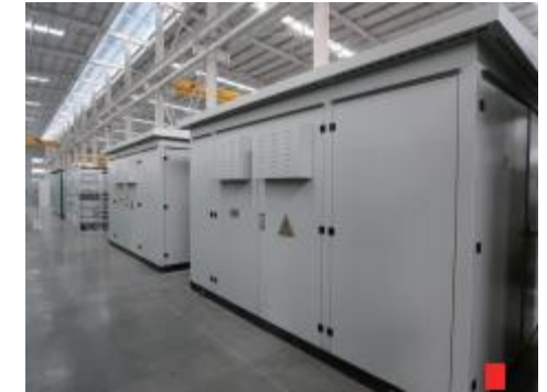
预装式变电站装配 Prefabricated substation assembly Assemblage de sous-stations pré-installées
