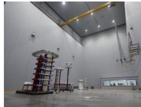
220KV实验中心 220KV Experimental Center Centre expérimental 220kV
