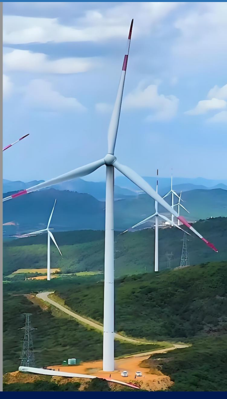
电力项目/Power Project
