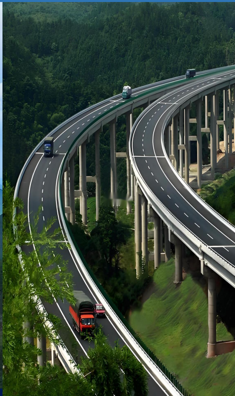
路桥项目/Road Bridge
