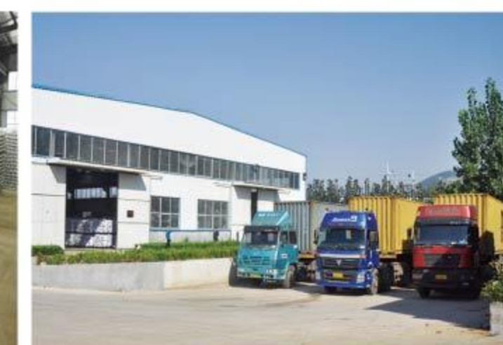
装箱平台 Container loading platform
