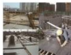
建筑模板 CONSTRUCTION FORMWORK
