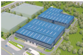
The factory in Wuhan (Being building) 武汉工厂（在建中）
