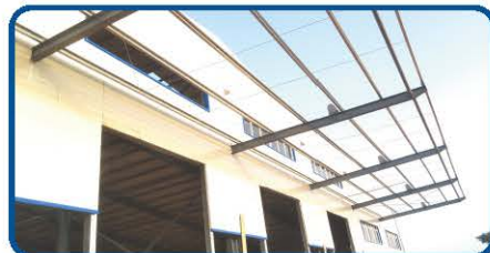
雨棚的安装 Install the canopy
