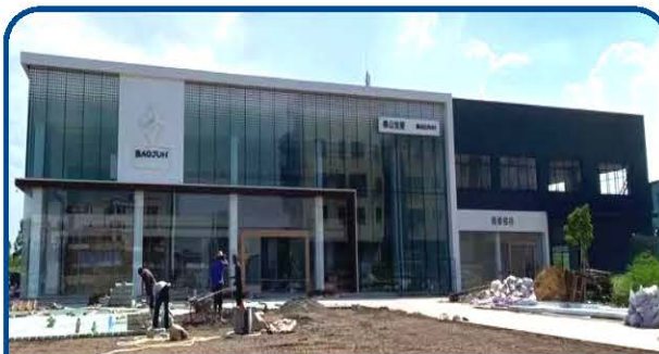
钢结构4S店 steel structure 4S shop
