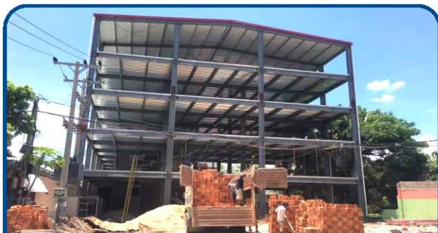
多层钢结构 5 floors super-market
