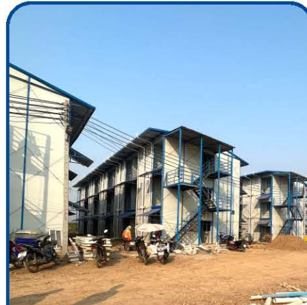
泰国3层项目 Project in Thailand
