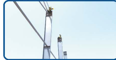
原杆 install the steel rod
