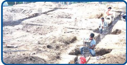
地基及预埋件 Foundation & embedded bolts
