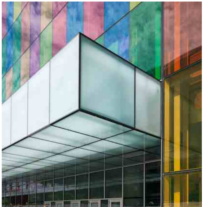
Office Curtain Wall 办公楼幕墙
