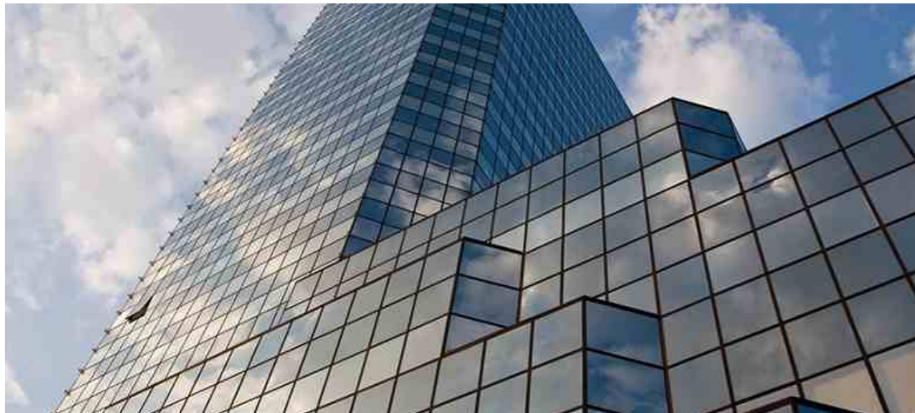
Office Curtain Wall 办公楼幕墙
