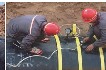
张家口智能管网项目-国内首次将管道监测系统应用于直径1400mm保温管的智能管网项目 Zhangjiakou intelligent pipe network
