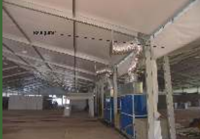
天沟布 Rain gutter
