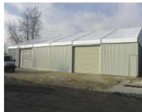
单层彩钢板 Steel sheet wall
