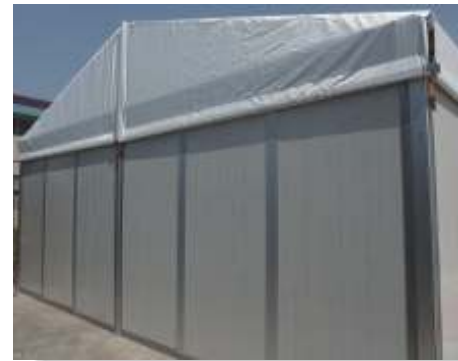
三明治板墙 Sandwich wall
