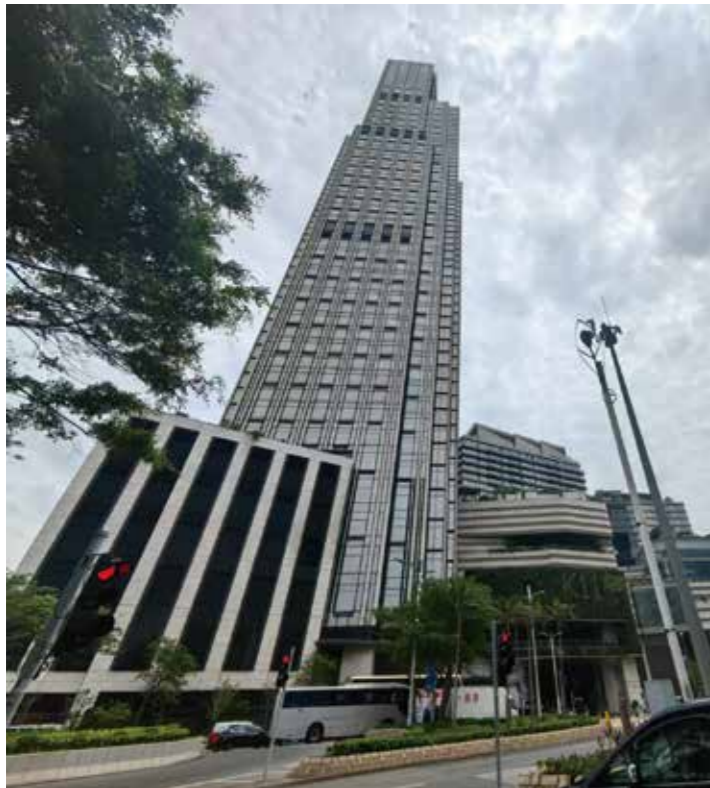
HONGKONG project TMT542
